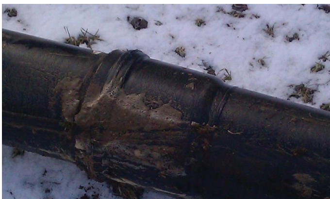
4.3. ábra: Kiásott csőkötés közelről, átm. 200 mm-es kiásott csövek Finnországban. Cső kód: F1
