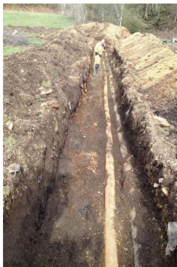
4.9.1. ábra: Kiásott átm. 160 mm-es, szerkezeti falú csövek. Norvégia, Surnadal. Cső kód: N2
