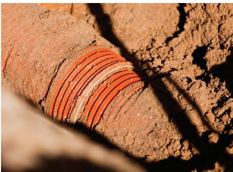
4.12.2. ábra: Szerkezeti falú cső az árokban
